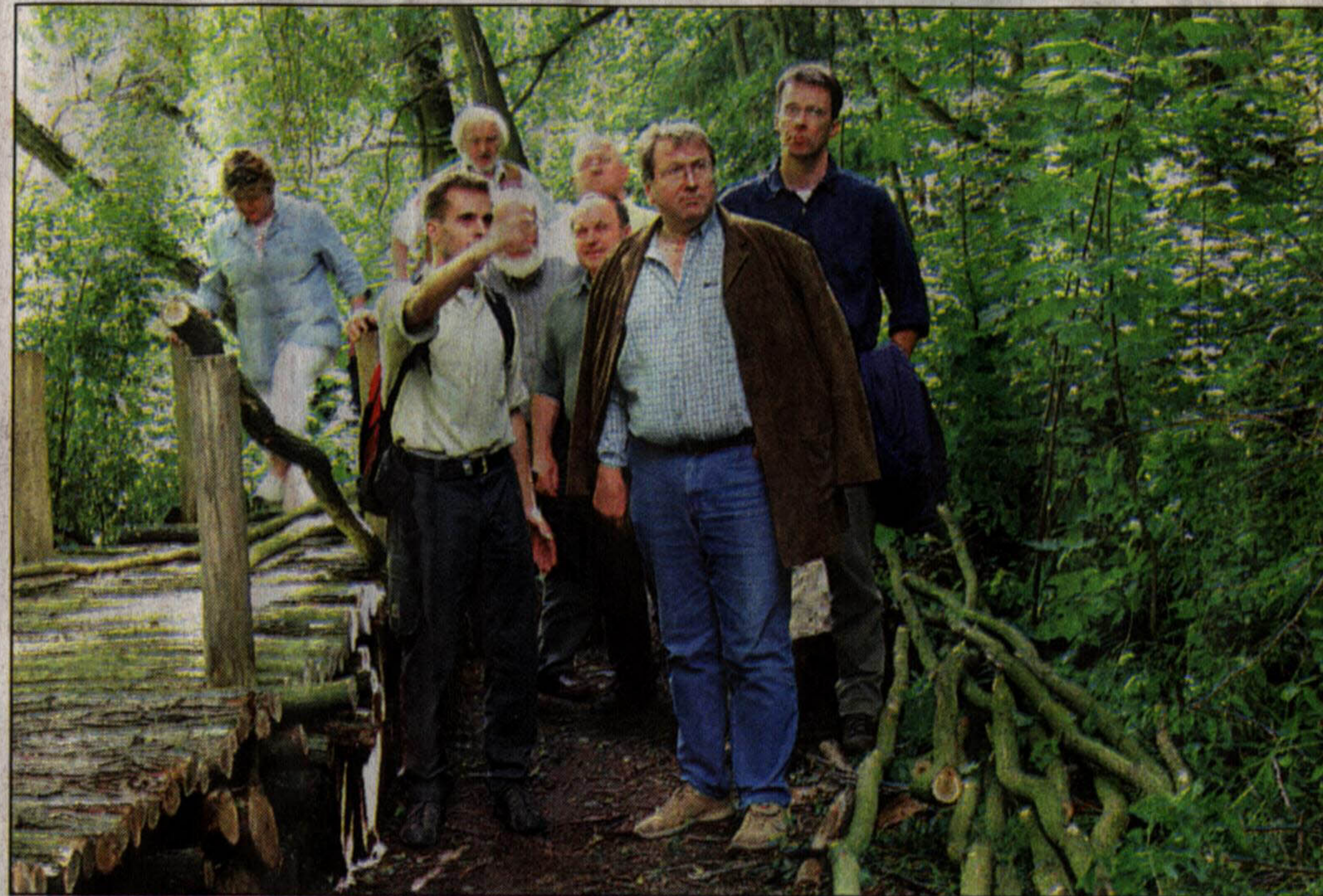
Auf dem Pfad durch die Glindower Alpen, wo ABM-Kräfte eine neue Brücke bauen, erläutert Kai Heinemann (l.) Maßnahmen, die zur Erhaltung des natürlichen Charakters beitragen könnten. FOTO: FW
